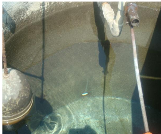
Interior del depósito
