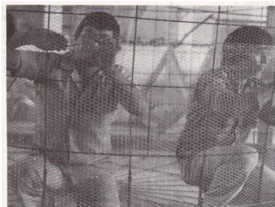
Figura 5. Colocación de malla hexagonal
